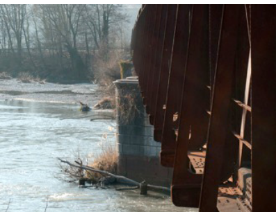
arrière-bec, côté aval
