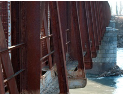
avant-bec, face au courant
